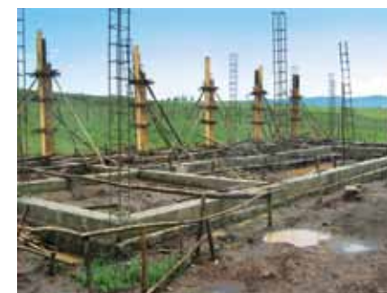
veehouderij in aanbouw
